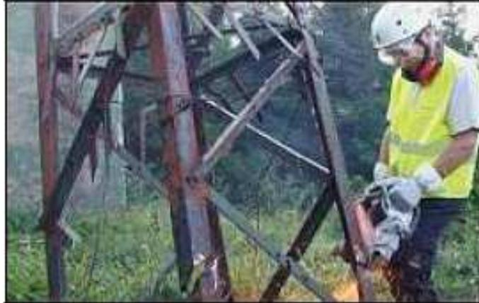
**NETTOYAGE.** Démantèlement des éléments métalliques du pylône hors d'usage.
